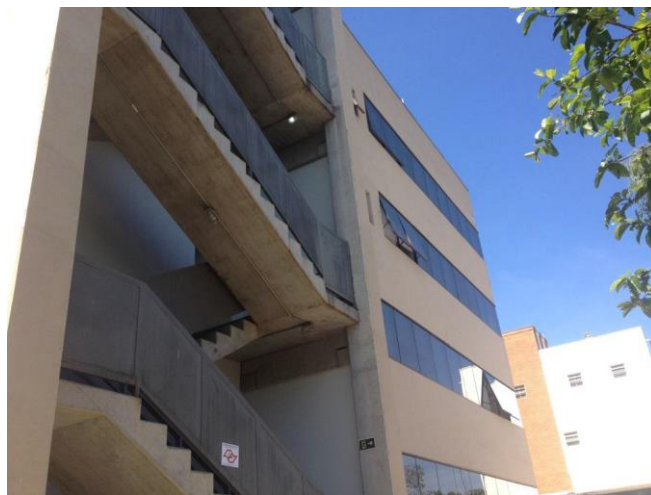
Fachada do Bloco Administrativo 02 – escada de emergência
