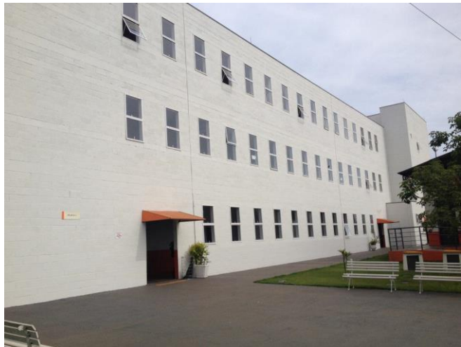
Bloco C – Fachada
