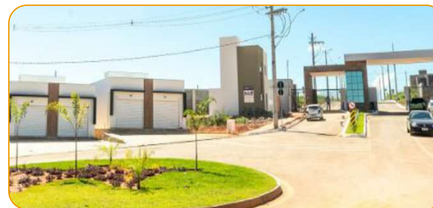
Entrada do empreendimento
