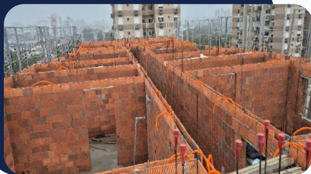
Foto 5: Andamento da obra
