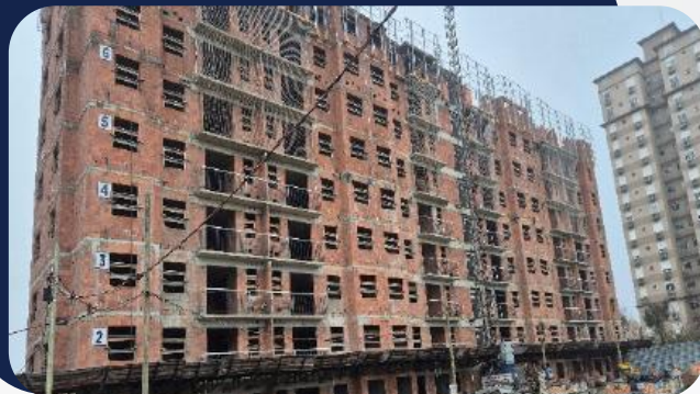
Foto 2: Andamento da obra
