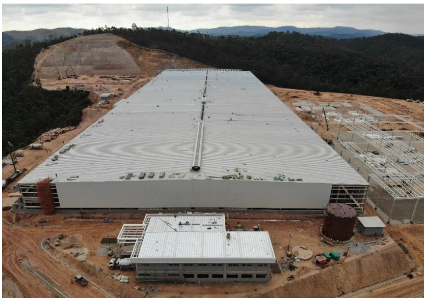
Execução de obras – Foto Panorâmica
