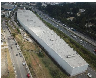
WTTP II Barueri, SP Av. Ceci, 1.649 Área construída: 24.654 m 2 * Participação: *80%
