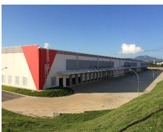
CD Renner São José, SC Av. Osvaldo José do Amaral, s/n Área construída: 47.913 m 2 Participação: 100%
