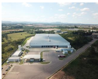
CD Via Varejo Cachoeirinha, RS Rua Lenine Queiróz, 333 Área construída: 38.410 m 2 Participação: 100%
