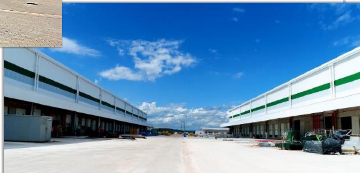
Área de carga e descarga
