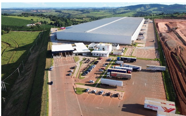
Imagem aérea do empreendimento.
