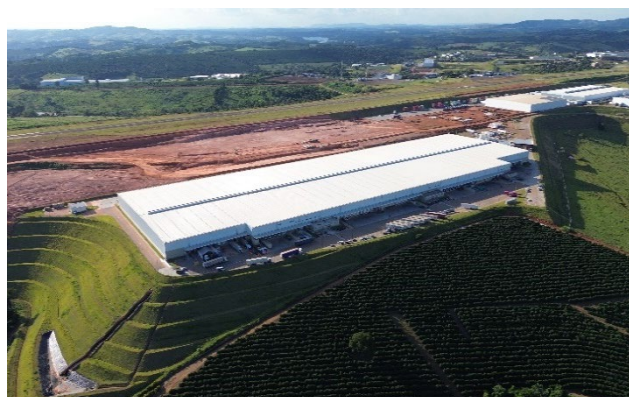
Imagem aérea do empreendimento.
