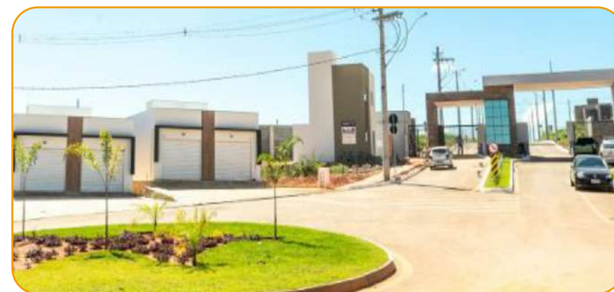
Entrada do empreendimento
