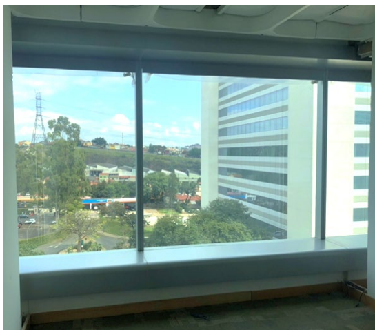
Vista Externa – Andar Tipo
