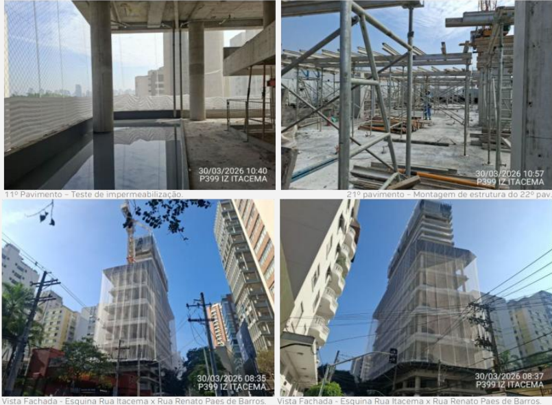
FOTOS DA OBRA
