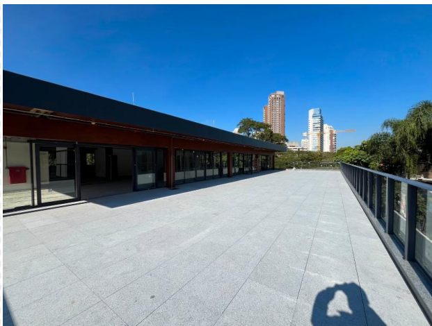
Piso elevado do 2º pavimento concluído
