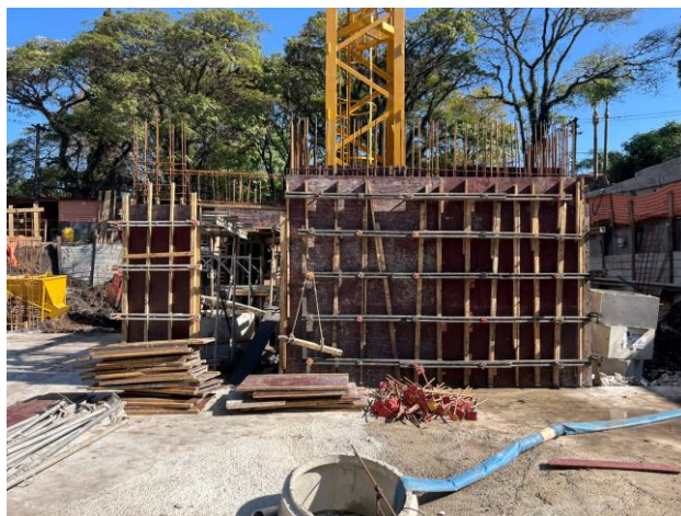
Formas e travamentos para execução de core dos elevadores - Torre Pedroso
