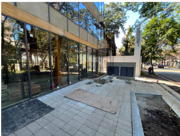
Execução de vedações da fachada e porte cochère
