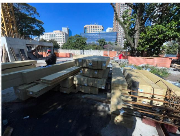
Recebimento de estruturas de madeira - Torre Ferreira
