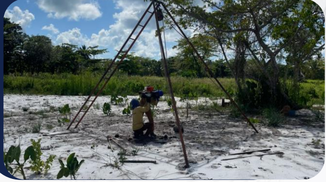
Foto 2: Sondagem do terreno
