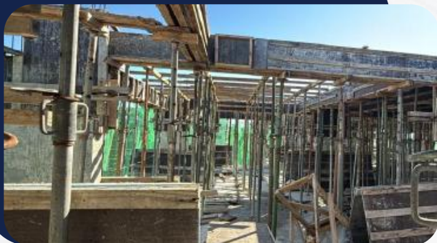
Foto 1: Estrutura – 10º Pav.
