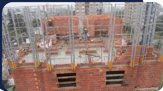
Foto 5: Andamento da obra
