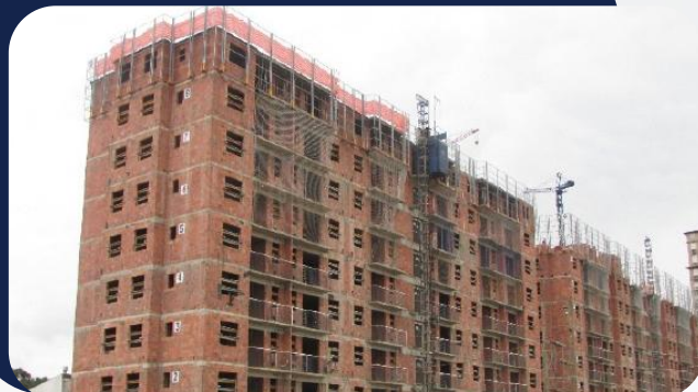
Foto 2: Andamento da obra
