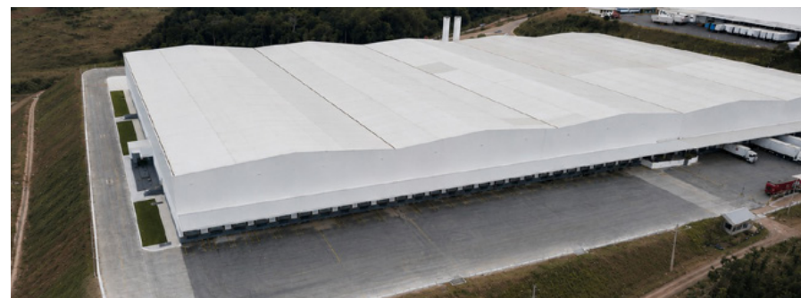
Área Externa do Galpão
