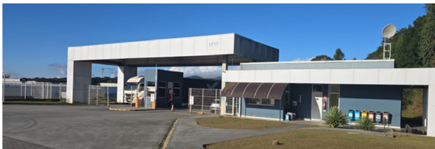
Portaria - Reforma de Cobertura - Renault
