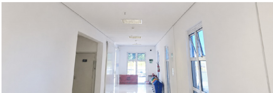
Acesso Vestiários e Refeitório – Reparos no Forro - Renault
