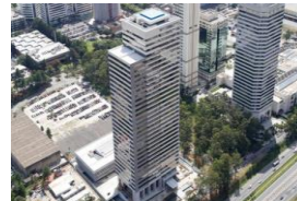
Aquisição dos conjuntos comerciais entre o 12º e o 31º pavimento do Edifício Corporate Evolution em Barueri/SP
