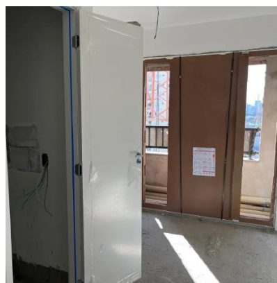
Vista interna unidade
