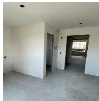
Vista interna unidade
