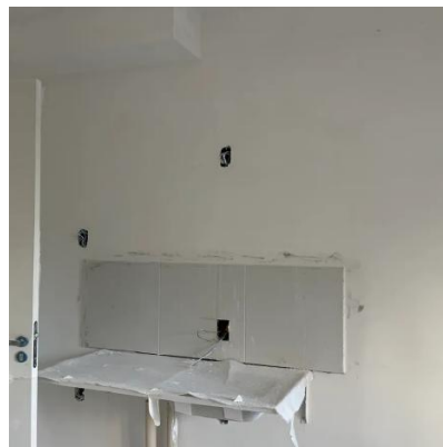
Vista interna unidade
