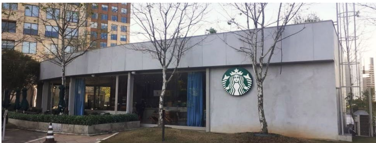
Em sentido horário: Edifício Continental Tower, heliponto, passarela de acesso ao Shopping Cidade Jardim e Starbucks na área comum.
