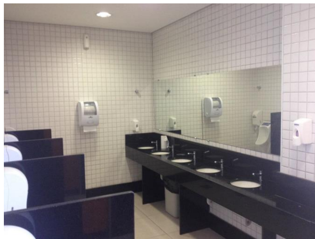
Bloco Administrativo 02 – sanitário
