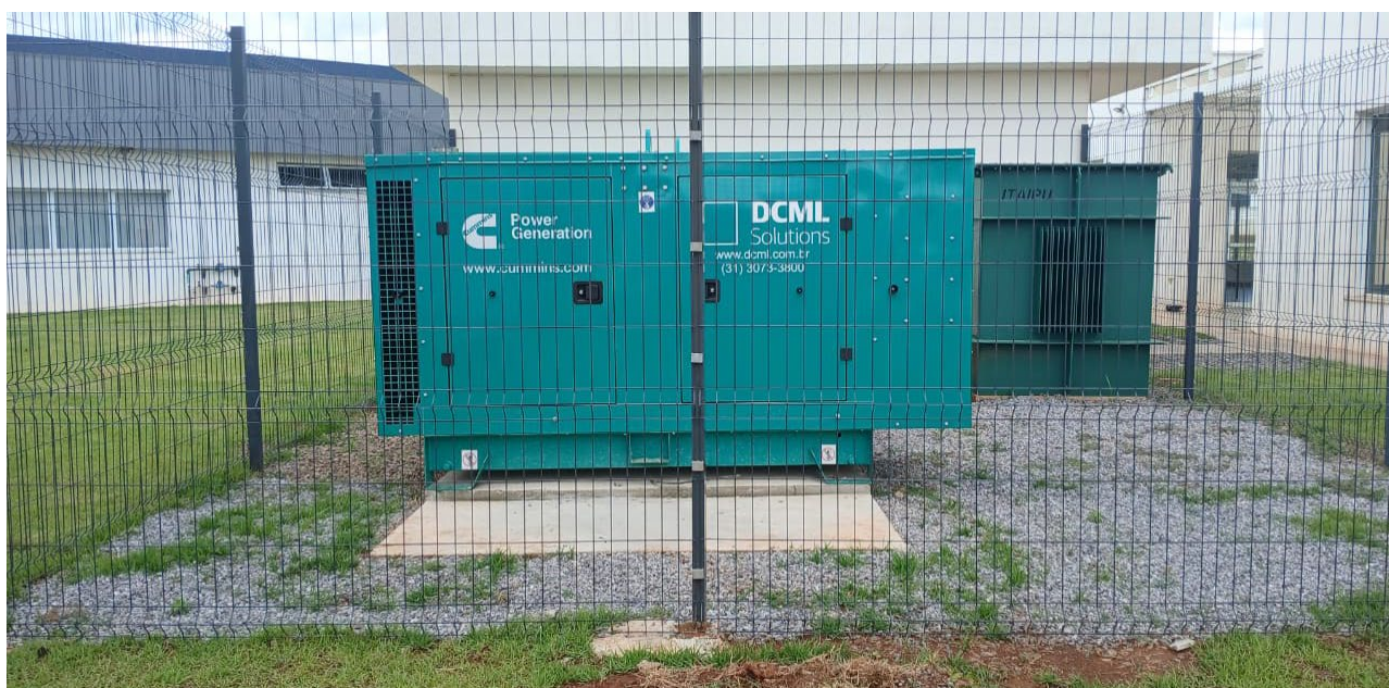
Instalação do novo gerador.
