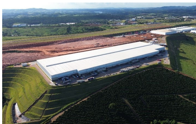
Imagem aérea do empreendimento.
