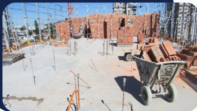
Foto 5: Andamento da obra
