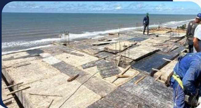
Foto 1: Forma 11º pavimento
