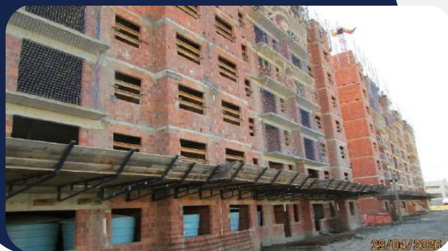
Foto 2: Andamento da obra
