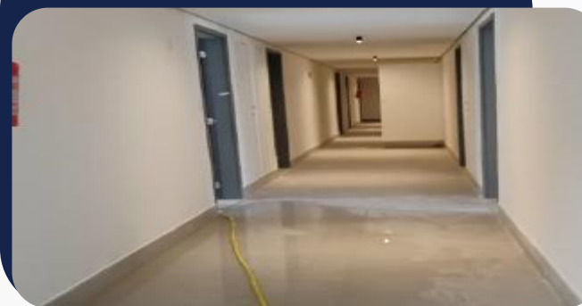
Foto 5: Limpeza do hall
