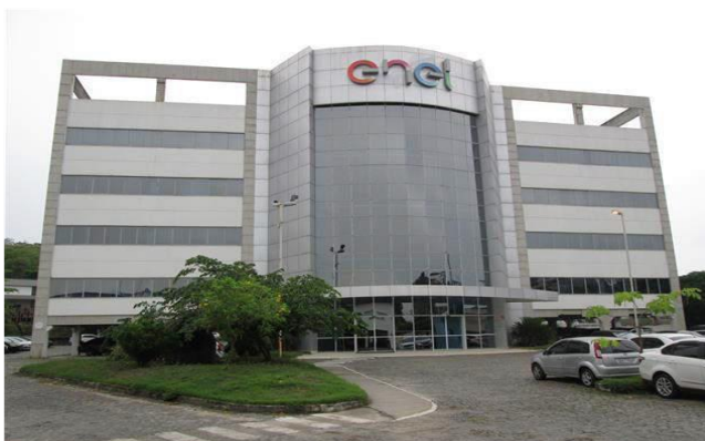
Ampla - São Gonçalo, RJ
