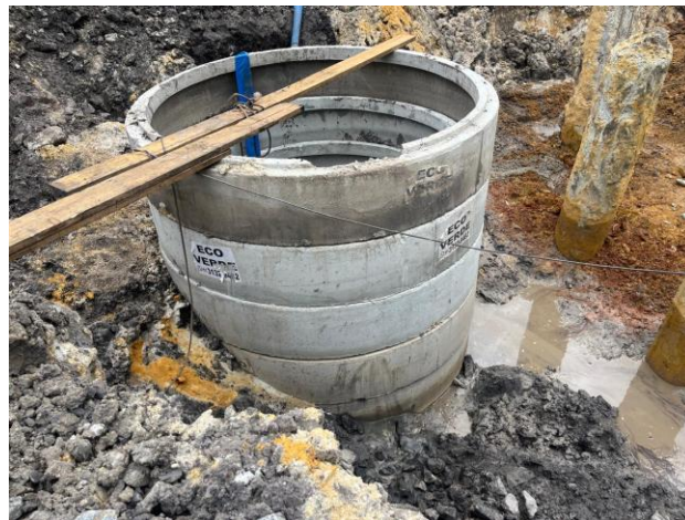
Início de poço de drenagem definitivo - Torre Pedroso
