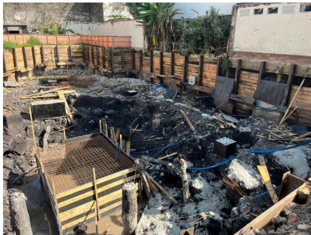
Armação de bloco do poço do elevador - Torre Ferreira
