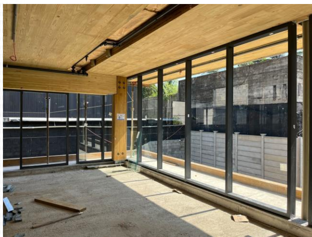
Instalação de vidros das fachadas dos fundos
