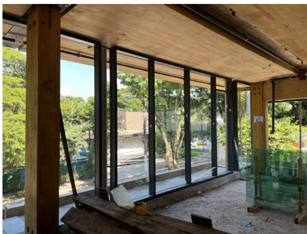
Instalação de vidros da fachada frontal
