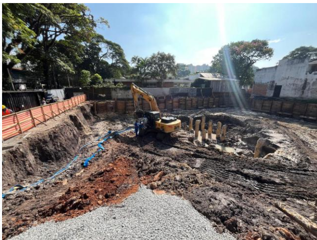
Visão geral - Torre Pedroso
