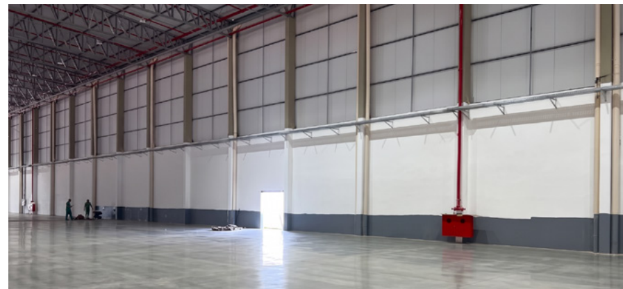
Piso do Galpão
