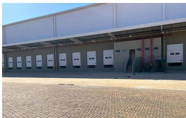
Docas e sanitários do galpão.
