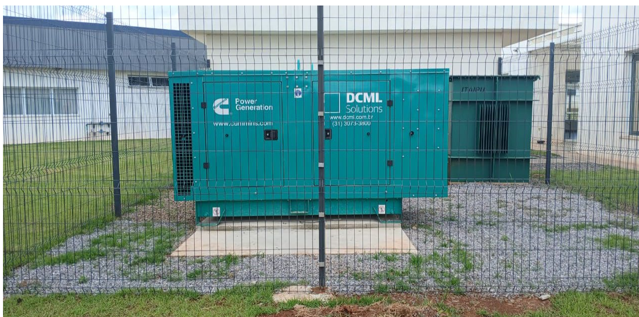
Instalação do novo gerador.
