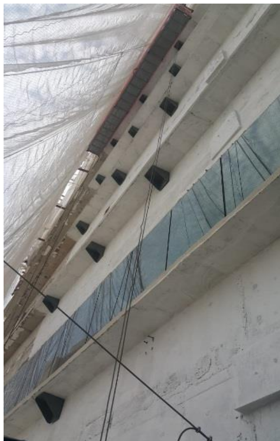
Tratamento e impermeabilização da estrutura da fachada
