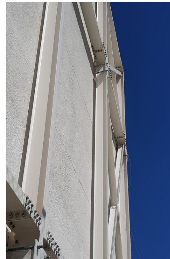
Restituição da Alvenaria do Chiller
