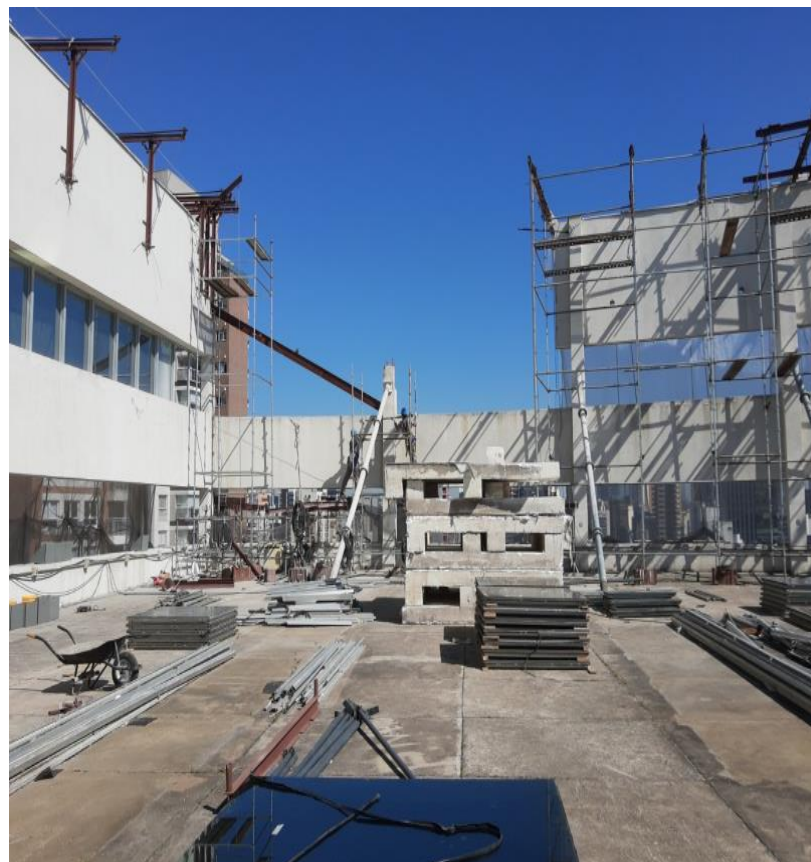
Restituição da Viga da Cobertura
