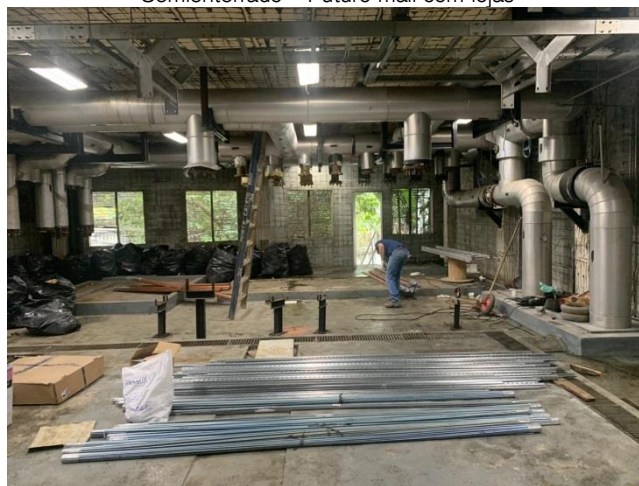
Remoção do sistema antigo de ar condicionado
