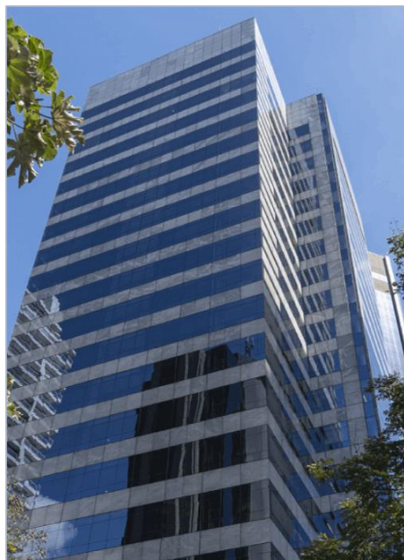
Ed. Torre Sul
