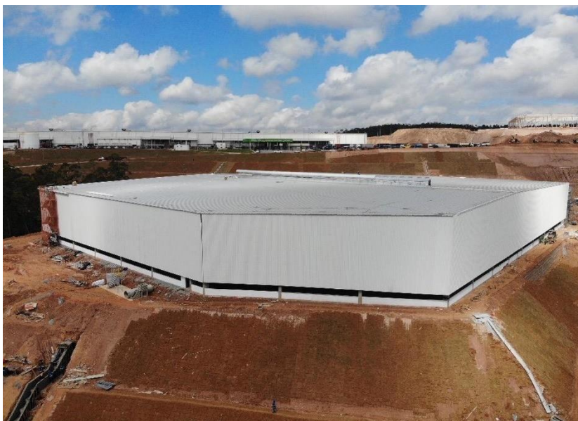
Execução de obras – Foto Panorâmica
