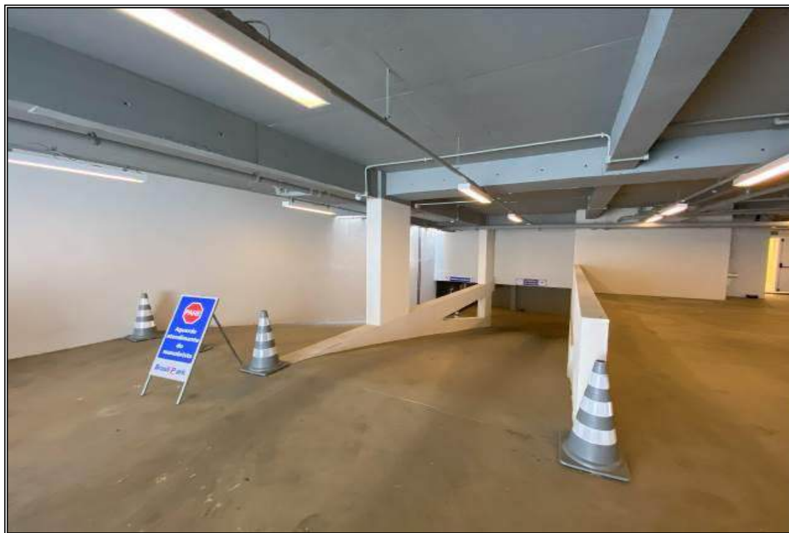
1º SUBSOLO - VISTA GERAL
