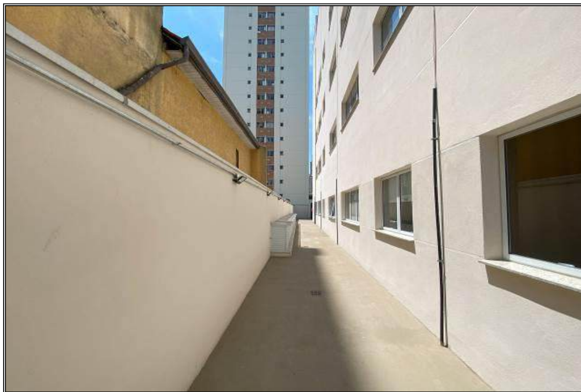
LATERAL DO PRÉDIO
