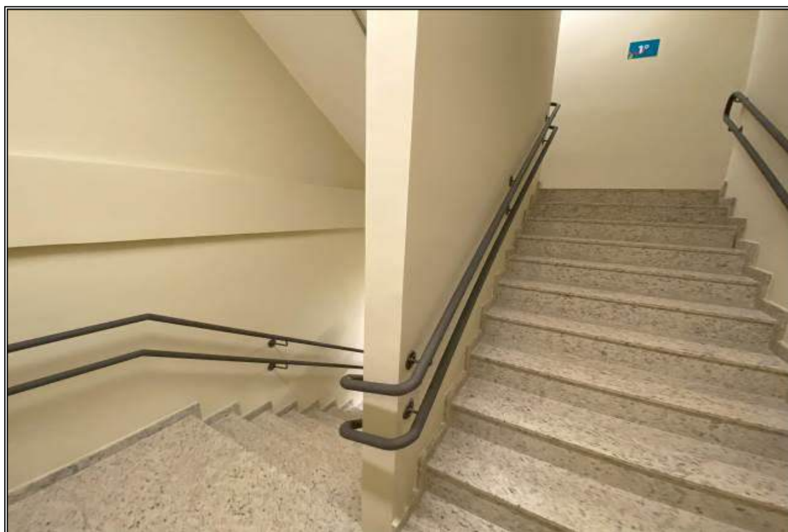
1º ANDAR – ESCADAS DE ACESSO
