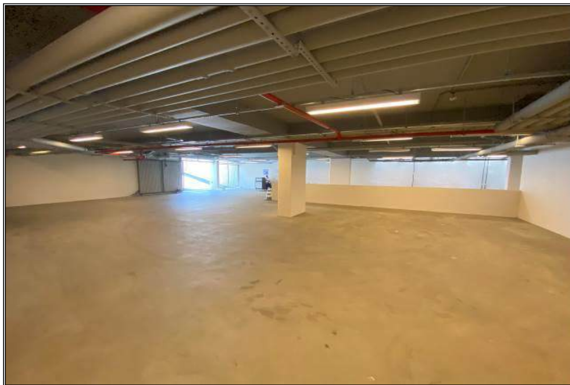
1º SUBSOLO - VISTA GERAL
