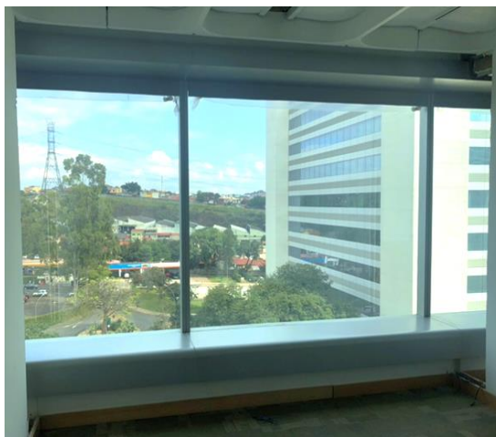
Vista Externa – Andar Tipo
