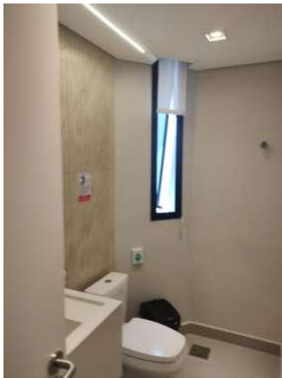
Conjunto nº 112 – sanitário
