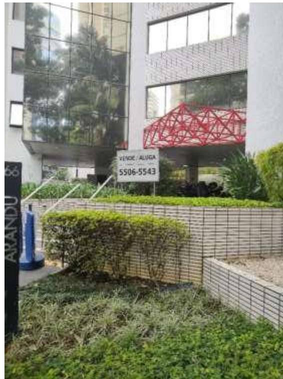
Acesso principal – área externa
