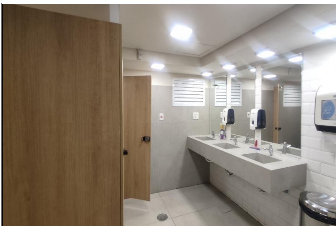
CONJUNTO 11 E 12 – SANITÁRIO
