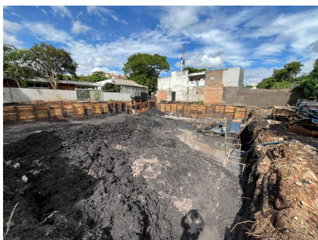
Visão geral de subsolo e pranchamento da cortina
