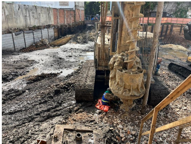
Manutenção em equipamentos de hélice contínua
