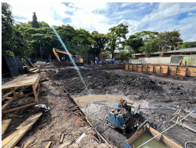
Escavação de solo
