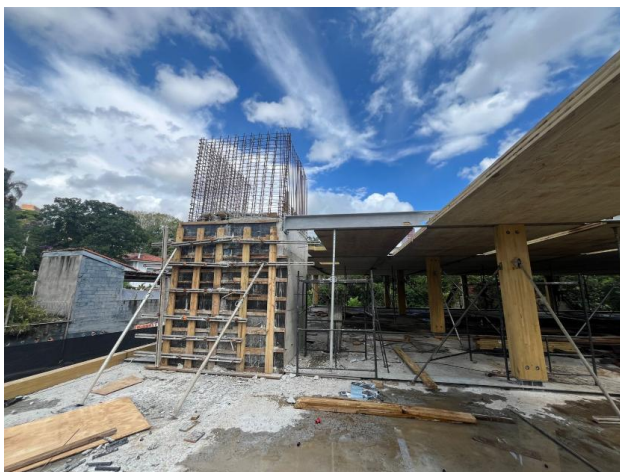
Forma e armação para core de concreto
