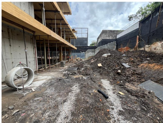
Movimentação de solo para drenagem
