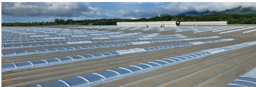
Cobertura do Galpão - Renault
