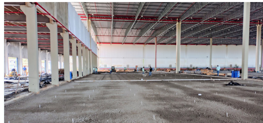
Concretagem do Piso do Galpão
