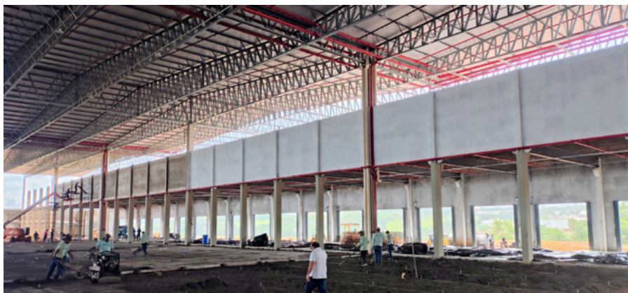
Execução de Alvenaria Perimetral Mezanino
