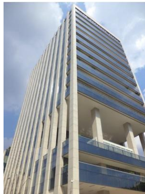
Fachada Traseira do Imóvel
