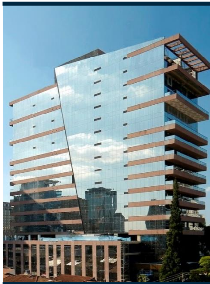
Fachada do Edifício The One
