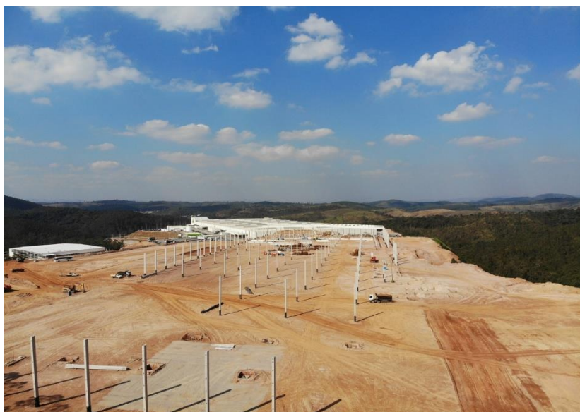
Execução de obras – Foto Panorâmica
