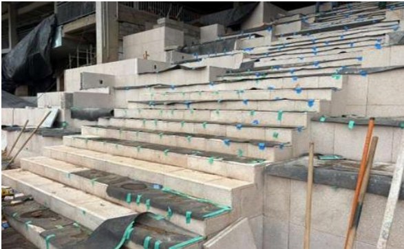
Deck Parking: Em andamento acabamento arquibancadas e finalizado instalação soleiras em granito da passarela metálica. Fonte: Alqia e HSI.
