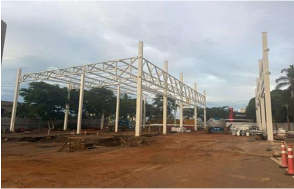
Expansão: Em andamento estrutura metálica. Fonte: Alqia e HSI.
