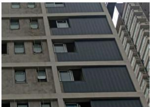
INSTALAÇÃO DO MINIWAVE FACHADA
