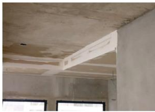
FORRO DE GESSO 10º PAVIMENTO
