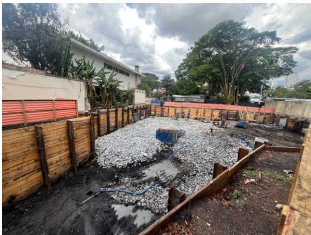
Distribuição de rachão para reforço do solo e drenagem provisória
