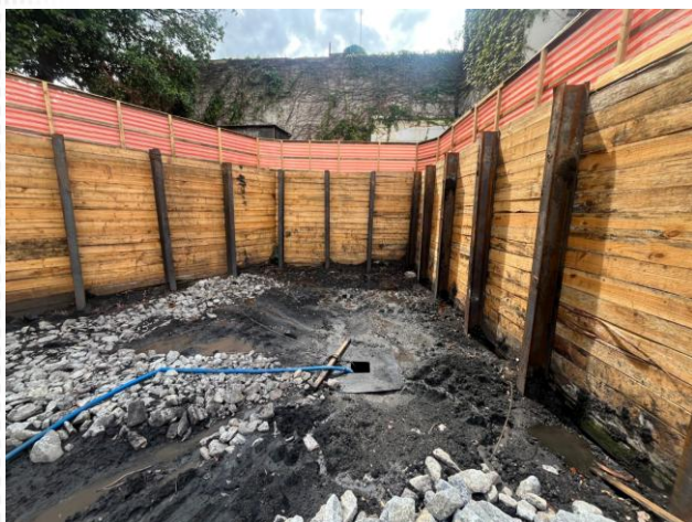
Prancheamento e poço de drenagem provisório
