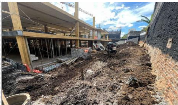
Escavação para drenagem dos fundos
