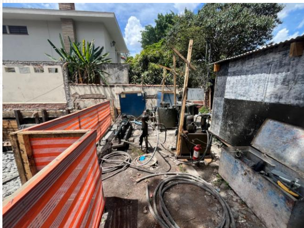
Equipamento para injeção de concreto dos tirantes
