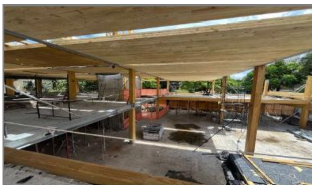
Lajes do pé direito duplo montadas
