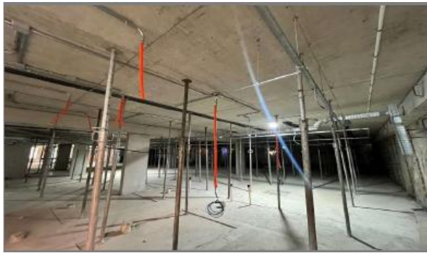
Infraestrutura área dos vestiários
