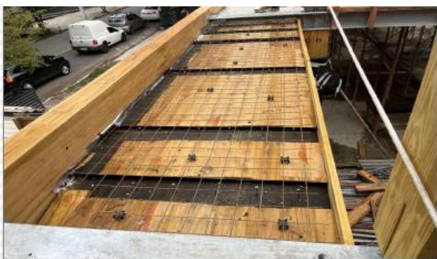
Laje preparada para concretagem
