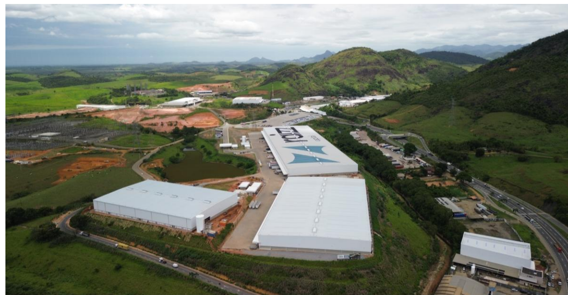
Construção Fase 2 (Galpão B e C) – Foto Panorâmica
