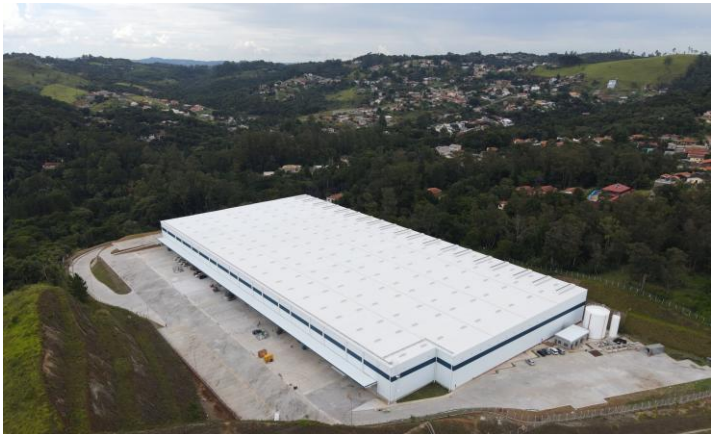
Imagem 2: Foto aérea do galpão
