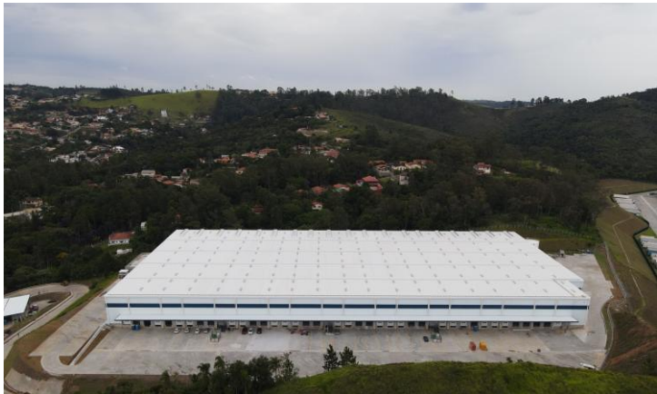
Imagem 1: Foto aérea do galpão
