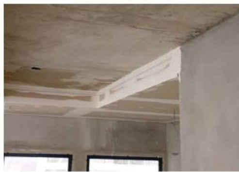
FORRO DE GESSO 10º PAVIMENTO
