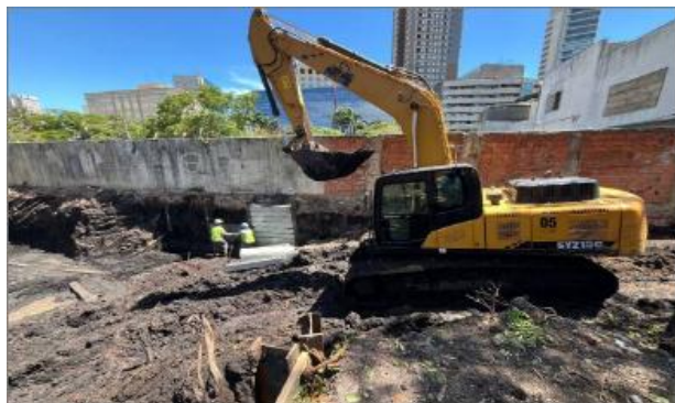
Escavação e retirada de terra
