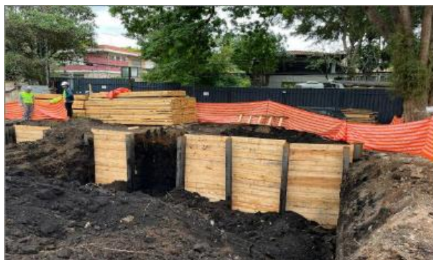
Início do pranchamento da torre Ferreira
