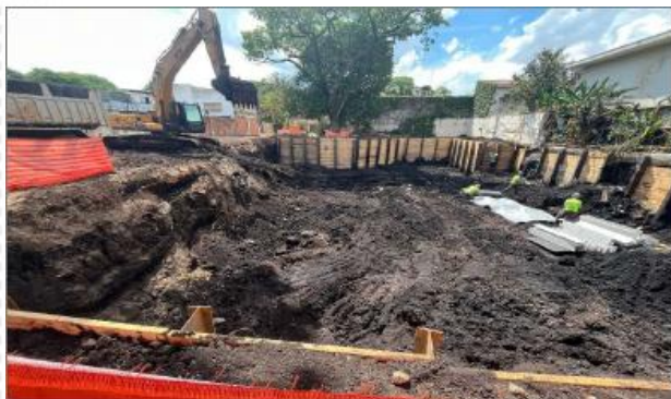
Escavação e pranchamento concomitante torre Ferreira
