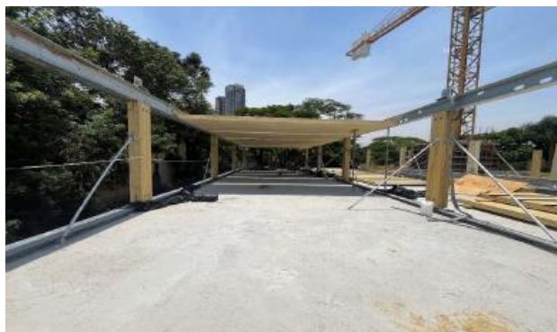
Montagem do trecho de laje A do 1º pavimento
