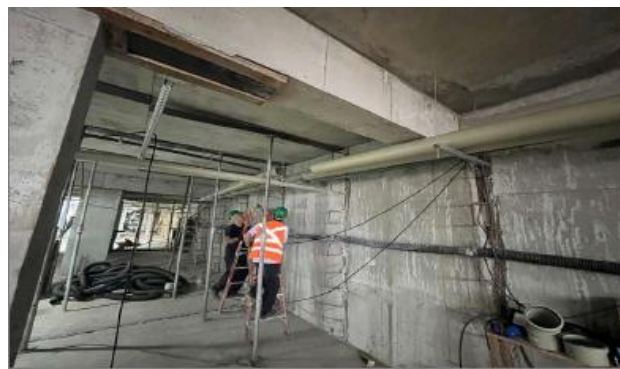
Execução de infraestrutura hidráulica em andamento
