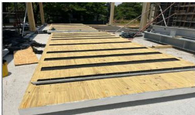
Preparação de laje no chão para engavetamento
