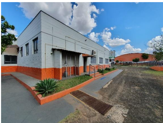
Vista Interna do Imóvel
