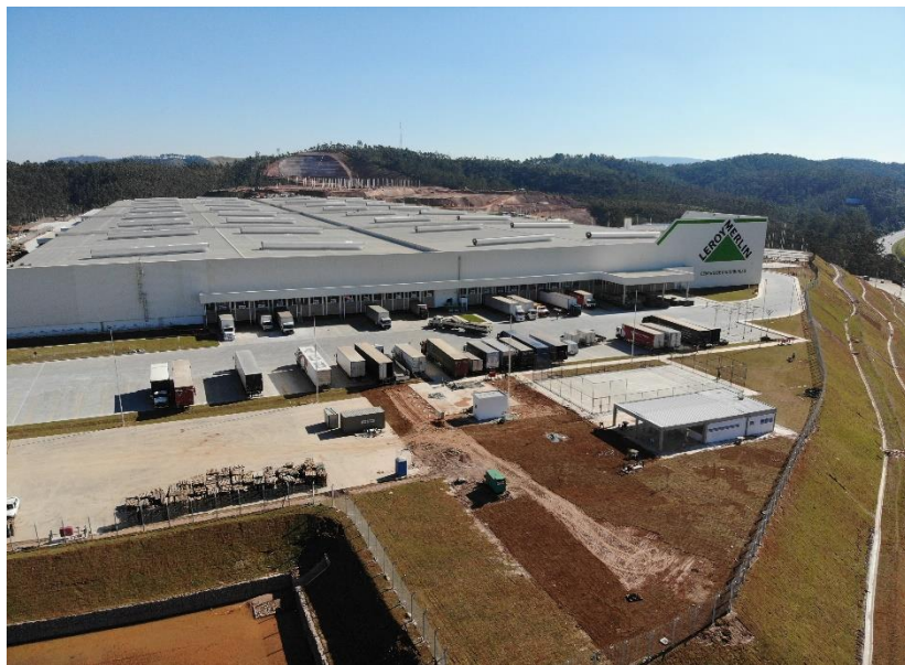
Execução de obras – Foto Panorâmica
