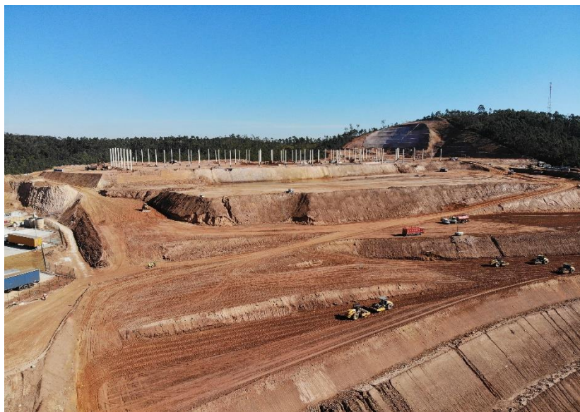
Execução de obras – Foto Panorâmica
