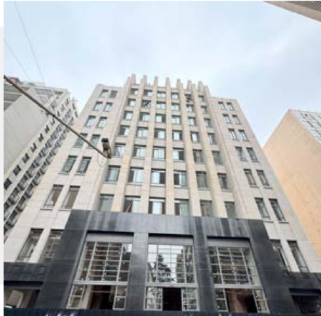
Fachada Bloco A Rua Sete de Abril (set/25)
