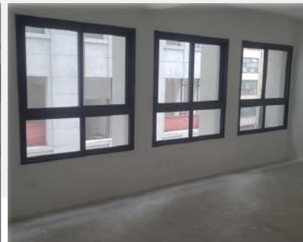
Esquadrias - 2º andar (set/25)
