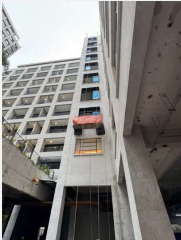
Fachada Bloco A1 (out/25)
