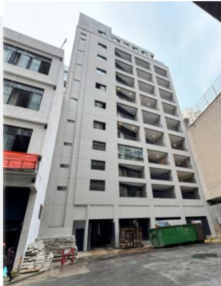
Fachada Bloco B Basílio da Gama (set/25)
