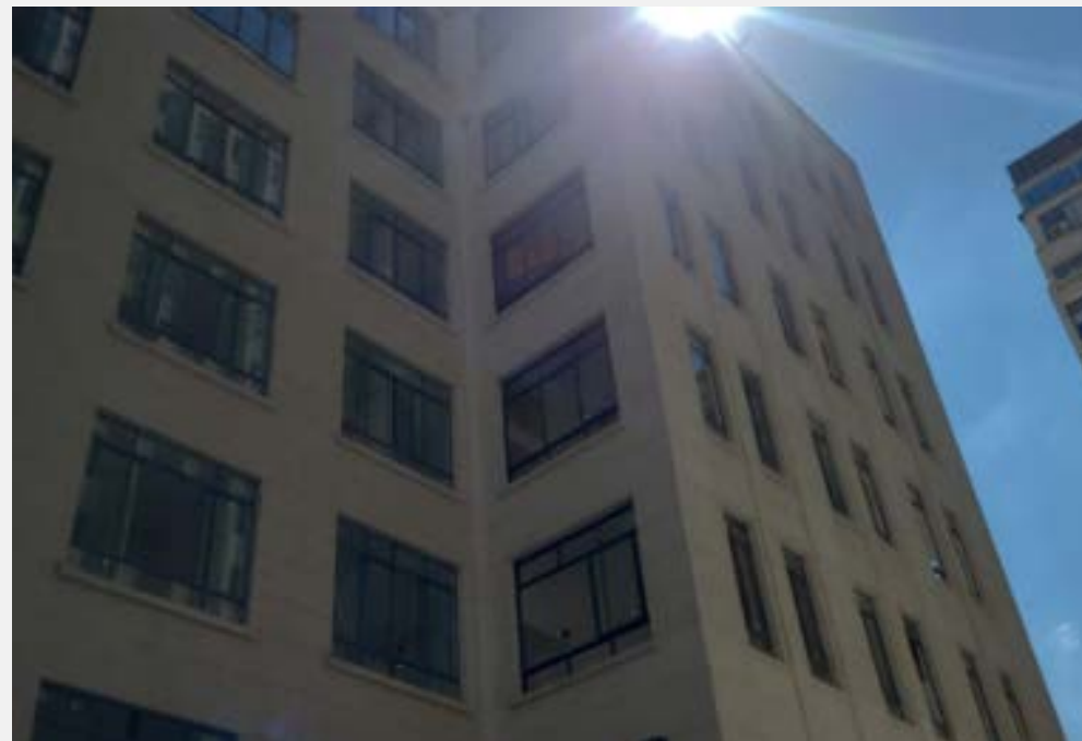
Fachada Bloco A2 Rua Basílio da Gama (set/25)
