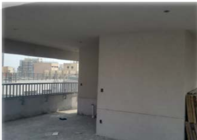
Textura, piso e gradil 14º andar (set/25)
