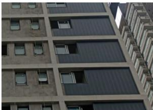
INSTALAÇÃO DO MINIWAVE FACHADA
