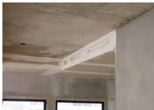
FORRO DE GESSO 10º PAVIMENTO
