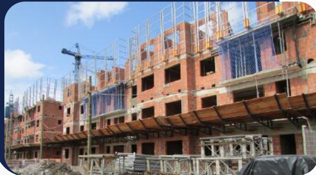
Foto 5: Andamento de Obra
