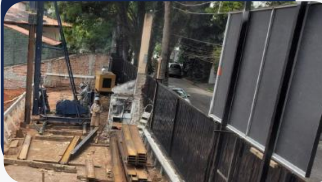
Foto 2 Cravação perfis metálicos
