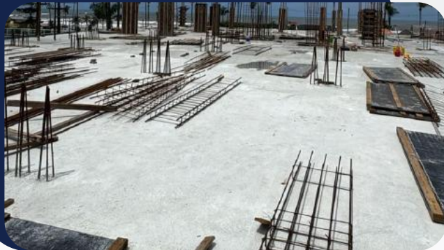
Foto 2: Vista da obra
