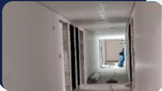
Foto 2: Forro de gesso
