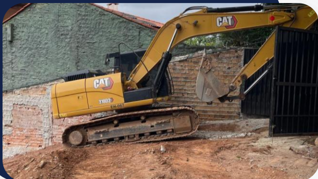
Foto 1: Andamento da obra
