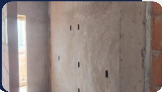
Foto 2: Reboco Interno
