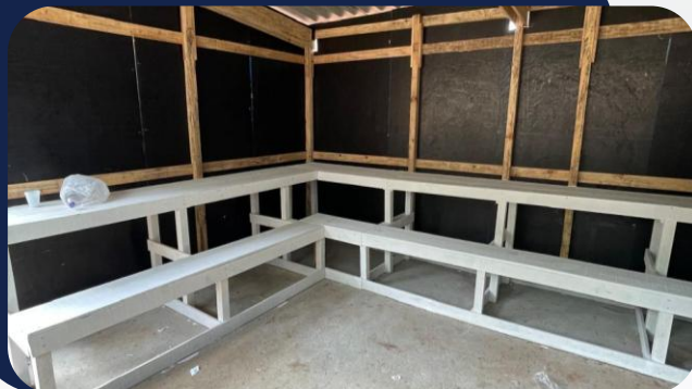
Foto 2: Instalações de obra
