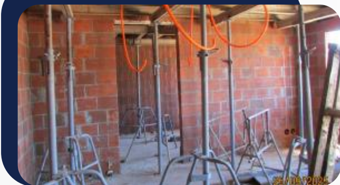
Foto 5: Andamento de Obra
