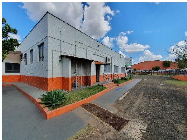
Vista Interna do Imóvel
