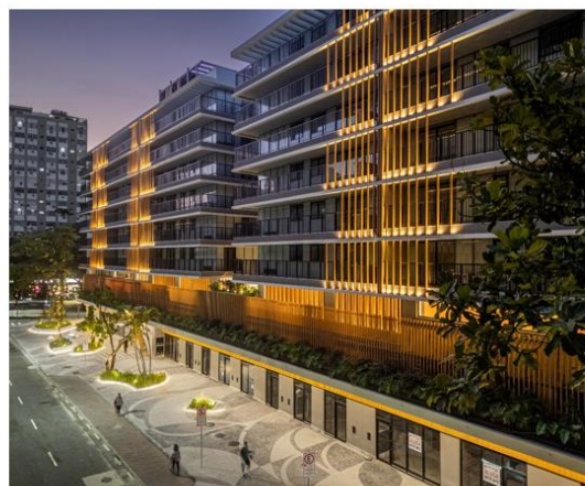
Fachada Essencia – Leblon Lançamento: 2022 | 100% vendido
